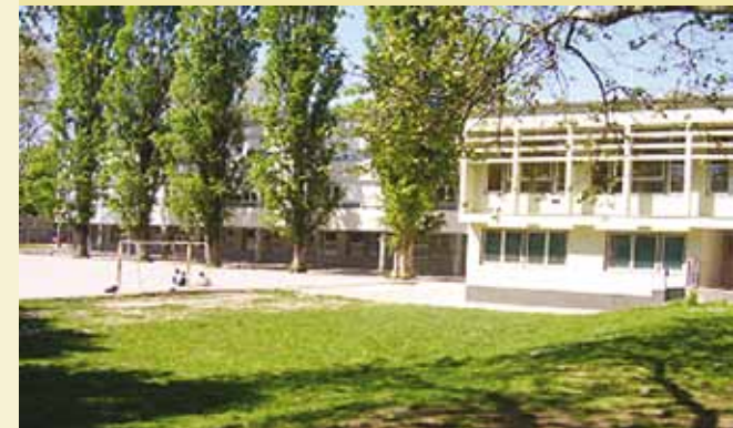
Pogled na obnovljenu školsku zgradu
